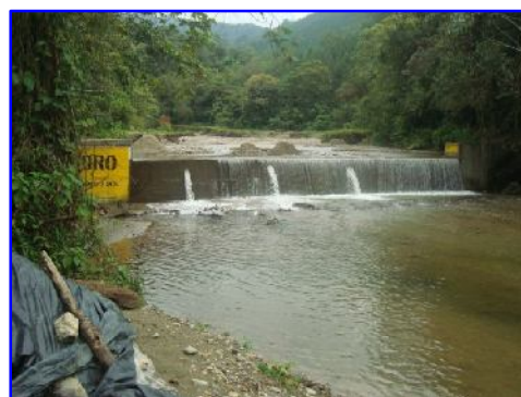
Presas mostrando tres vertimientos funcionando, ya que con la dinámica del río se tapan fácilmente
